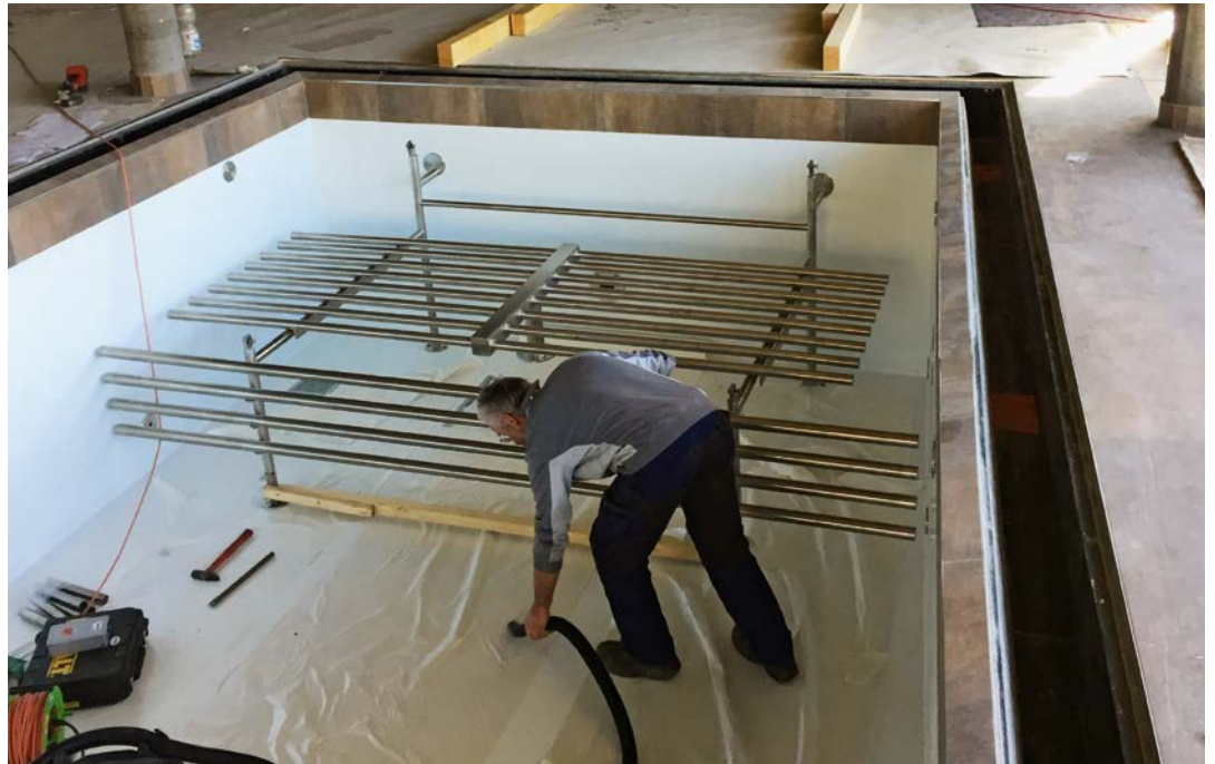
Edelstahlrohre werden montiert.
